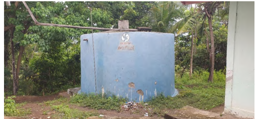
Een waterbak gerealiseerd in 2015 welke nog steeds in gebruik is door de basisschool (foto 2023).
